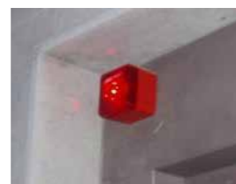
Luz exterior de montacoches ocupado
